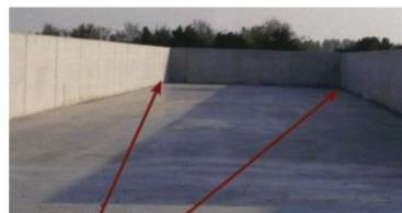
Wenn das Fahrsilo am hinteren Ende geschlossen wird, muss im letzten Element ein Chromstahl – U-Profil einbetoniert sein, dies ermöglicht eine perfekte Abdichtung der Ecke.
