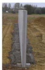
**Für Elemente ab 220 cm Höhe sollten die Elemente einbetoniert werden.**
