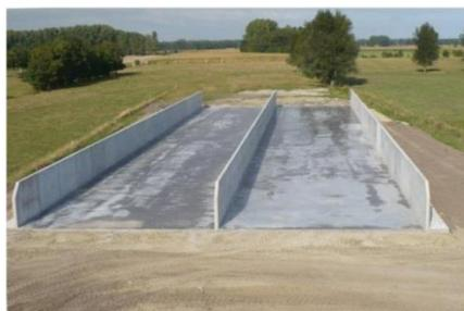
Für die Produktion unserer Fahrsiloelemente setzen wir immer Beton mit HSR – Zement (High Sulfate Resistance) ein. Die Armierung wird unter Verwendung von BENOR-zertifiziertem Armierungsstahl im Betonwerk hergestellt.
