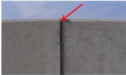
Die Übergänge zwischen den Elementen (Nut – Kamm) werden beidseitig mit Silikon abgedichtet.
